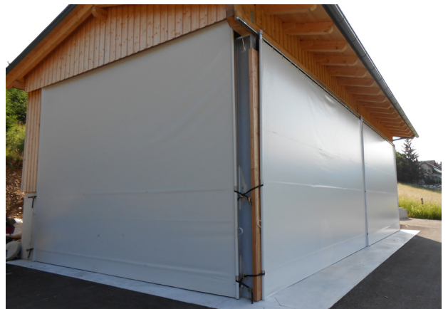
Mehrteiliges Vorhangelement mit Laufschiene befestigt samt Spannmechanismus in der Länge.
