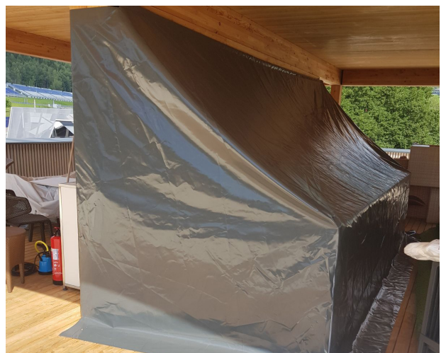
Schutzplane für Stiegenabgang gegen Schlagregen. Montiert mit Kederschiene und Klettverschlüssen an den Seiten.
